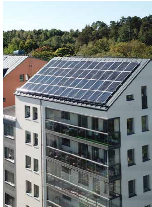
Solpaneler på ett av våra hyreshus i Upplands Väsby
